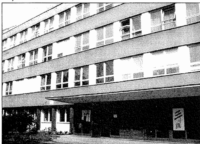
Vcelku obvyklá školní budova.
